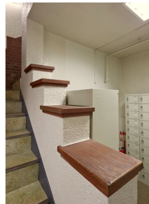
地下1Fの階段手摺
